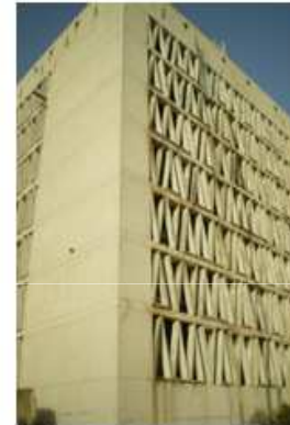
Dispositif de protection solaire avec film réfléchissant
