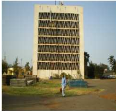
Dispositif de protection solaire avec film réfléchissant
