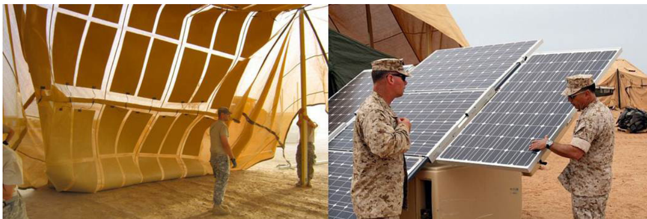
Fig. 1. Tente et installations militaires solaires
